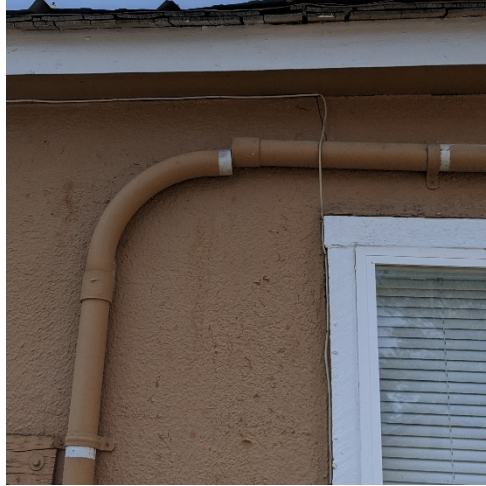
Conduit Separation
